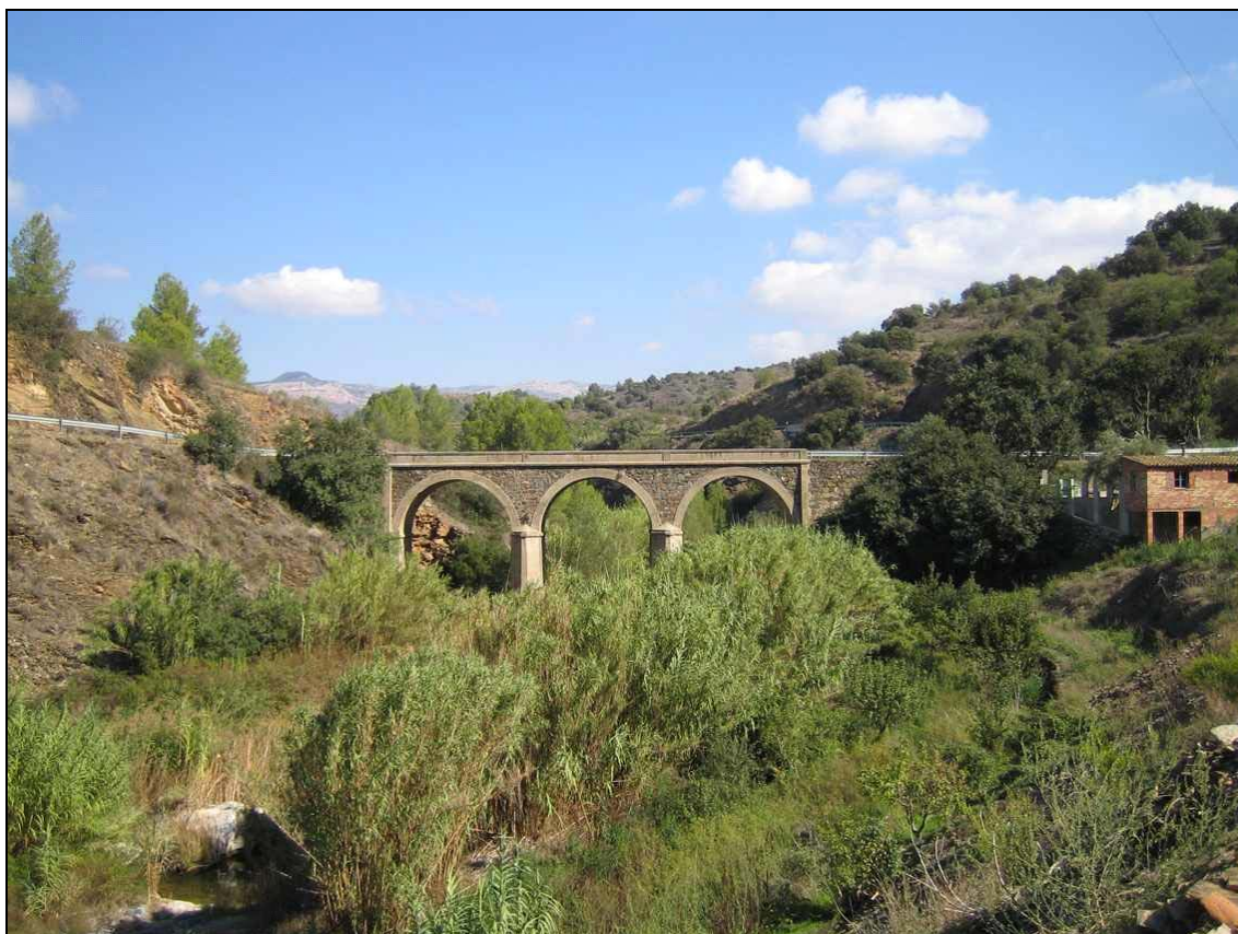
Fig. 10. Pont sobre el riu Montsant a la carretera de Gratallops al Lloar.
